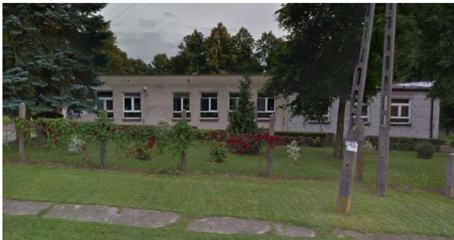
Rysunek nr 1. Budynek WTZ w Wiardunkach, który przeznaczony jest do termomodernizacji Źródło: https://www.google.pl/maps
